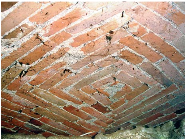
Ryc. 9. Podchybie. Dwór. Wysklepek nad помещением 004 w przyziemiu. Fot. M. Bicz-Suknarowska 2004
