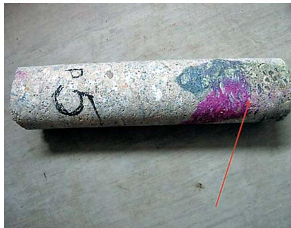
Ryc. 10. Odwiert O-5 – głębokość karbonatyzacji około 63 mm Fig. 10. Core bore-hole O-5 – depth of carbonatisation app. 63 mm
