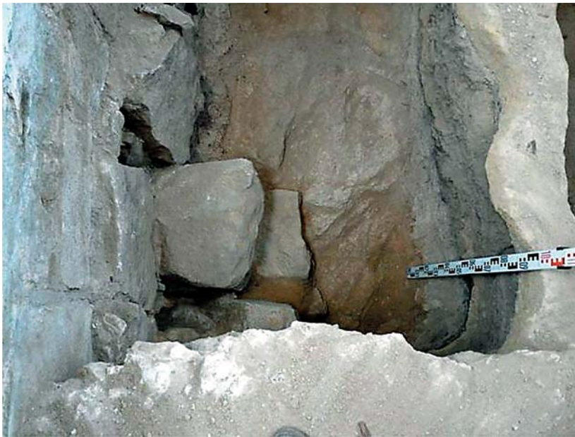
Ryc. 6. Relikt fundamentu ściany poprzecznej w prezbiterium. Fot. Cz. Hadamik Fig. 6. Relics of the foundation of the crosswise wall in the presbytery. Photo: Cz. Hadamik
