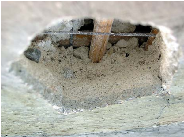
Ryc. 5. Uniwersytet Wrocławski, Aula Leopoldina; sonda w części sklepienia nad podium obrazującą układ warstw zbrojenia i tynku. Wyraźnie odróżnia się wierzchnia warstwa intonaco, z powodu wtrąceń węgla drzewnego i popiołu. Fot. Ewa Skrzydlak, 2008 Fig. 5. University of Wrocław, Aula Leopoldina; probe in the vault section over the dais, revealing the arrangement of reinforcement and plaster layers. Clearly visible surface layer of intonaco, because of charcoal and ash inclusions. Photo by Ewa Skrzydlak, 2008
