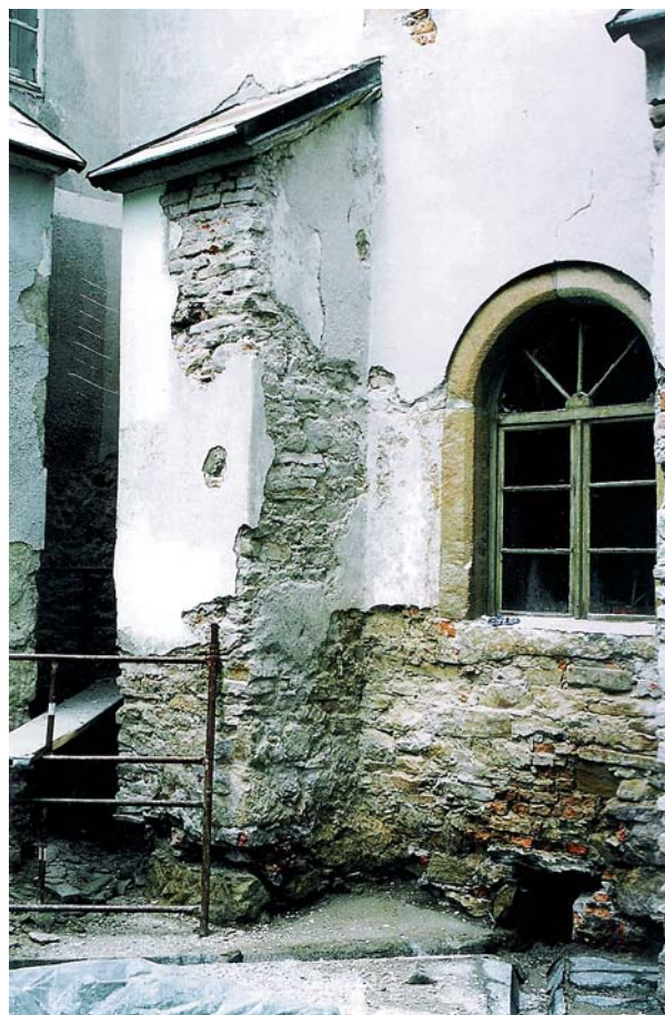
Ryc. 15. Elewacja północna z lokalizacją sondy nr 1, odcinek A i B. Pod oknem w skrajnej lewej osi parteru widoczny otwór wlotowy kanału odwadniającego wirydarza. Oprac. A. Bojęś-Białasik Fig. 15. North elevation with location of probe no 1, section A and B. Inlet of the canal draining the garth is visible under the window in the extreme left ground floor axis. Made by A. Bojęś-Białasik
