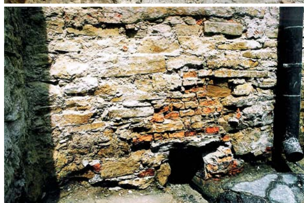
Ryc. 16. Wlot kanału odpływowego w ścianie północnej wirydarza; widok wlotu kanału po zбициu tynku z elewacji oraz podczas kontynuacji prac remontowych. Fot. B. Kwiatkowska-Kopka, 2004 Fig. 16. Inlet of the drainage canal in the north wall of the garth; view of the canal inlet after hacking off plaster from the elevation and during the continuing renovation work. Photo B. Kwiatkowska-Kopka, 2004
