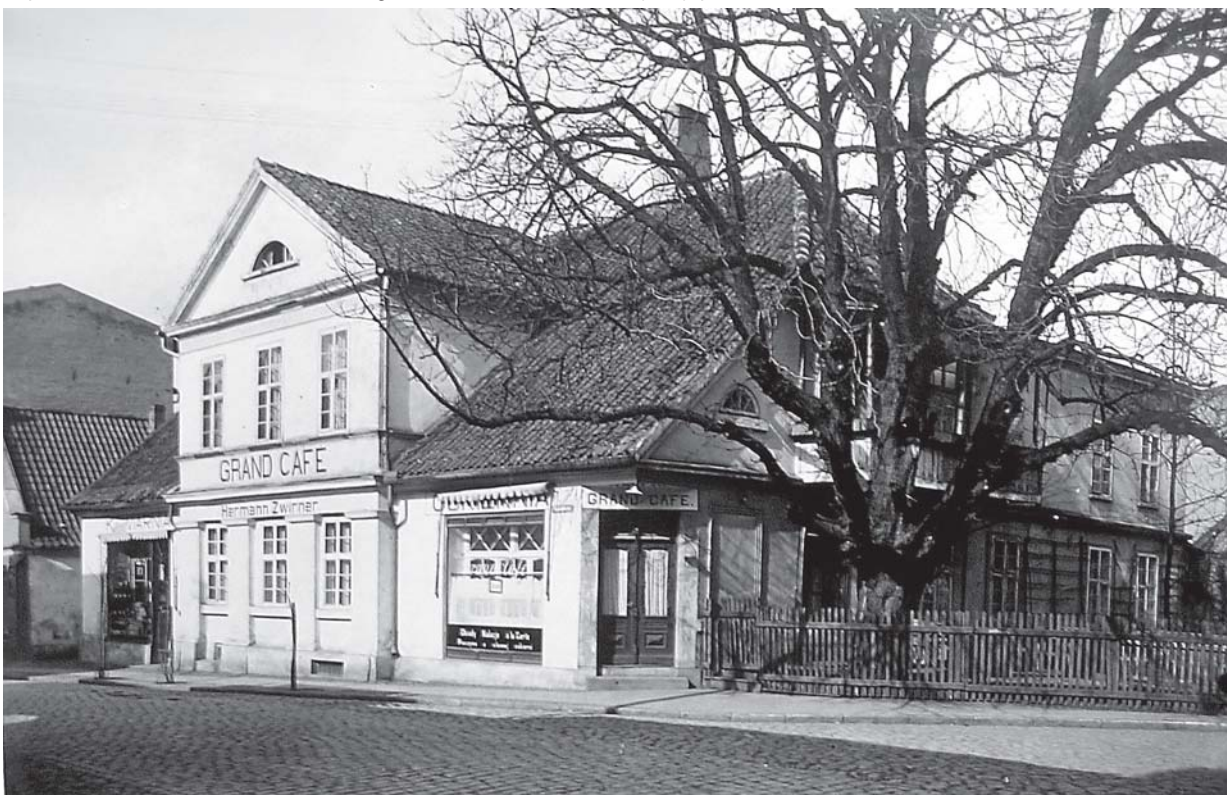
Ryc. 3. Dom przy ul. Kamionka 2 w Brodnicy, uznany orzeczeniem konserwatorskim za zabytek w 1931 r. W wyniku odwołania właściciela i magistratu orzeczenie zostało uchylone, ze względu na zły stan techniczny budynku i akcję regulacji miasta na tym terenie. APB, UWP w Toruniu, sygn. 24606 Fig. 3. House at 2 Kamionka Street in Brodnica, pronounced a monument by a conservator's ruling in 1931. As a result of the owner's and Magistrate's appeal the ruling was repealed, because of the poor technical condition of the building and the action of regulating the town in this area. APB, UWP in Torun, sign. 24606
