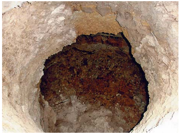
Ryc. 10. Podchybie. Dwór. Otwór studni wykopanej w piwnicy 005. Fot. M. Bicz-Suknarowska 2004
