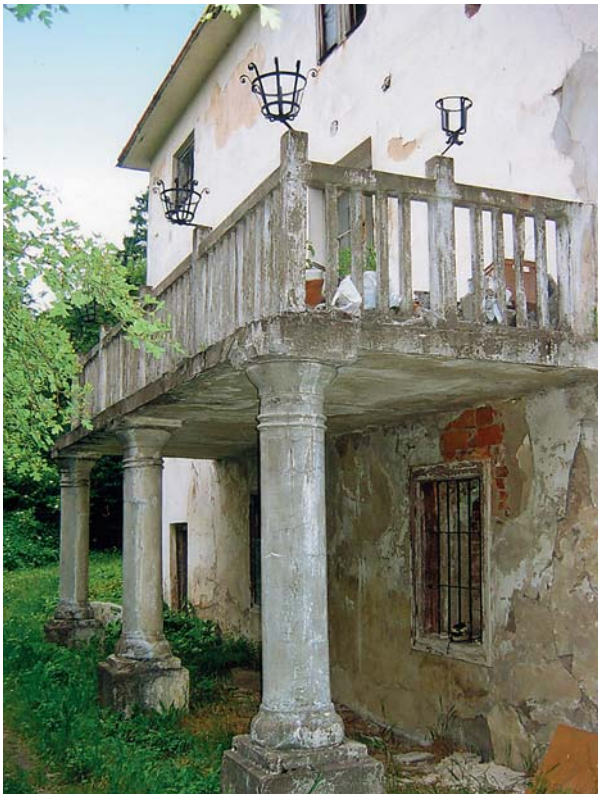
Ryc. 8. Podchybie. Dwór. Taras na betonowych kolumnach przy elewacji południowej, pod tarasem okno kuchenne. Fot. M. Bicz-Suknarowska 2004
