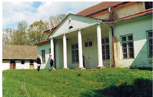
Ryc. 7. Podchybie. Dwór. Ganek elewacji zachodniej. Na dalszym planie budynek gospodarczy. Fot. M. Holewiński 2004 Fig. 7. Podchybie. Manor house. Porch of the west elevation. A utility building in the background. Photo: M. Holewiński 2004
