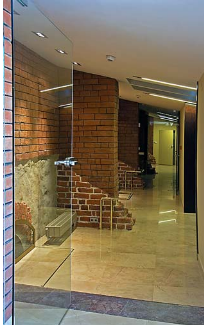
Ryc. 12. Pomieszczenie cafe baru z ekspozycją konserwowanych wątków gotyckich Fig. 12. Coffee bar room with the exhibition of the preserved Gothic bonds
