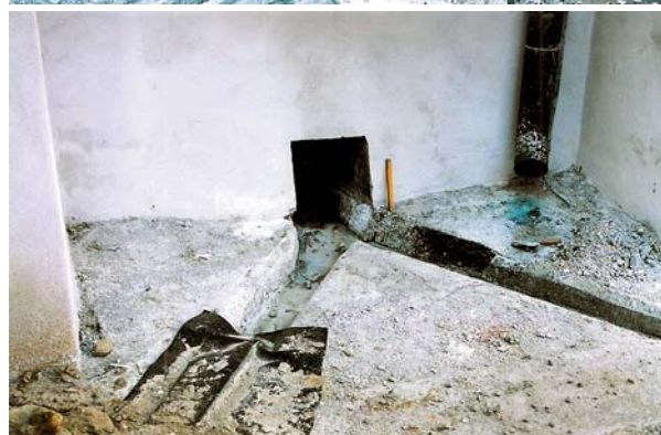
Ryc. 17. Widok z góry odsłoniętego kanału odwadniającego, biegnącego wzdłuż południowej elewacji południowego skrzydła klasztoru. Fot. B. Kwiatkowska-Kopka, 2004 Fig. 17. View from above of the uncovered drainage canal, running along the south elevation of the south wing of the monastery. Photo B. Kwiatkowska-Kopka, 2004
