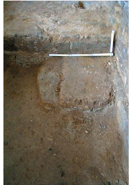
Ryc. 9. Pierwotny poziom użytkowy (w postaci fragmentarycznie zachowanej wylewki wapiennej) zarejestrowany w tzw. Sali Rycerskiej. Fot. K. Stala
