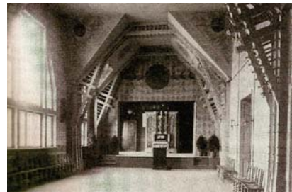
Ryc. 7. Budynek byłej szkoły prywatnej, wnętrze. Ryga. J. Madernieks, ok. 1910 Fig. 7. Building of the former private school, interior, Riga. J. Madernieks, app. 1910
