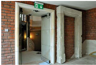
Ryc. 6. Nowe ościeże w przedsiönku wyjścia na taras z neogotyckim ościeżem Prylińskiego Fig. 6. New jamb in the porch to the terrace with a neo-Gothic jamb by Pryliński
