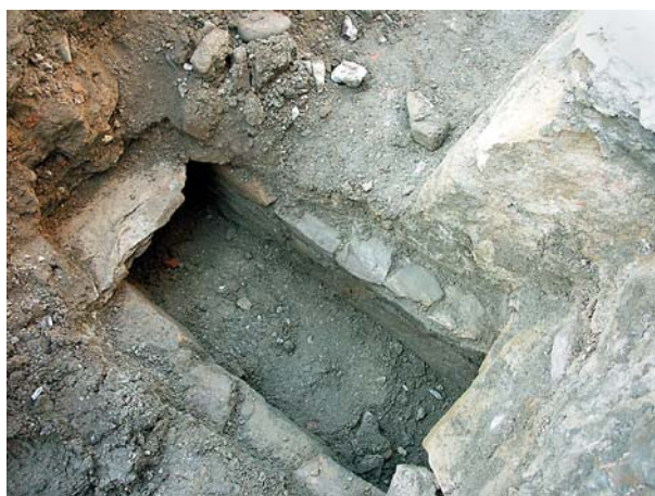
Ryc. 17. Widok z góry odsłoniętego kanału odwadniającego, biegnącego wzdłuż południowej elewacji południowego skrzydła klasztoru. Fot. B. Kwiatkowska-Kopka, 2004 Fig. 17. View from above of the uncovered drainage canal, running along the south elevation of the south wing of the monastery. Photo B. Kwiatkowska-Kopka, 2004
