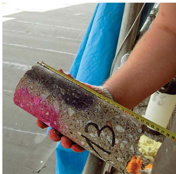
Ryc. 11. Odwiert O-13 – brak karbonatyzacji ( \text{pH} \geq 13 ) Fig. 11. Core bore-hole O-13 – no carbonatisation ( \text{pH} \geq 13 )
