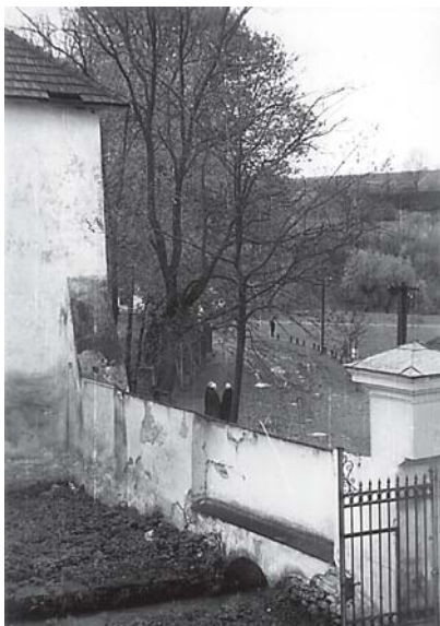
Ryc. 8. Zachodni mur ogrodzeniowy klasztoru; widoczne wąskie koryto młynówki oraz sklepiony przepust rzeki w murze. Fot. B. Lisowski, 1944
