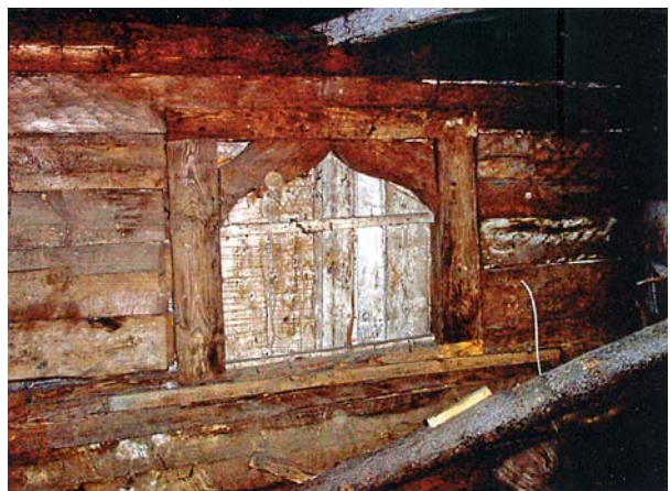
Ryc. 11. Podchybie. Dwór. Okienko w narożniku północno-wschodnim nad skośną przybudówką zakończone lukiem w ośli grzbiet. Fot. M. Bicz-Suknarowska 2004
