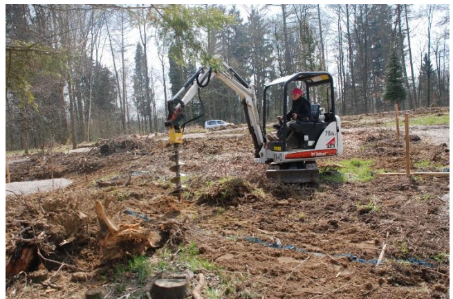
Abbildung 67: Lochbohrung mit Kleinbagger
