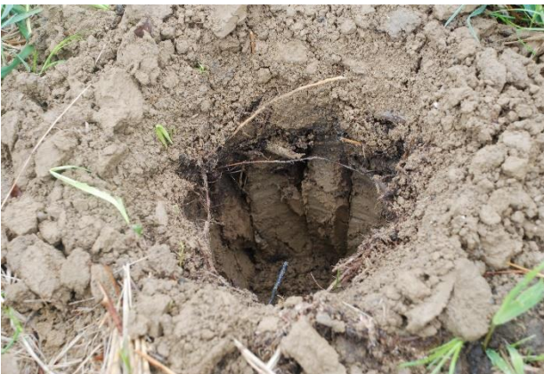
Abbildung 70: Aufrauhen der Bohrlochwand
