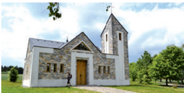
Využitím místních zdrojů kamene je podpořena lokální identita venkovského prostoru, Rudice.
