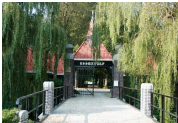
|Afbeelding 52 Begraafplaats Esserveld in Groningen wordt door middel van een hekwerk in Amsterdamse Schoolstijl afgesloten van de omgeving. Achter het hek staat het poortgebouw waarin onder andere een aula is gerealiseerd.
