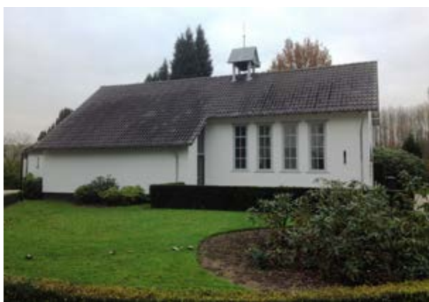
|Afbeelding 47 Aula op de begraafplaats in Kerk-Avezaath (Gelderland). Deze kleine aula is in traditionele stijl opgetrokken. Bouwjaar 1937. Het linker deel is later aangebouwd.
