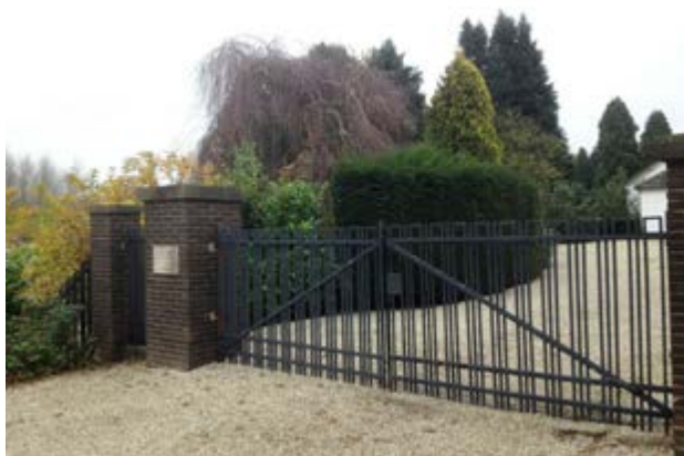
| Afbeelding 84 Hekwerk met pilaren bij de ingang van de begraafplaats. Over het geleverde werk omtrent de dekplaten waren opdrachtgever en -nemer het niet eens.
