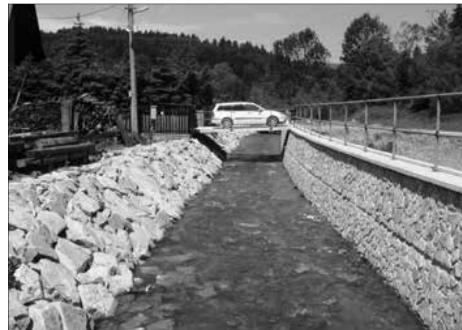
Obr. 2. Pucov – dotácia na protipovodňovú ochranu v roku 2009 a 2010 – Tok Pucov, úprava toku v rkm 3,625 – 3,945 a 4,210 – 4,560 Fig. 2. Pucov – grant for antiflood protection in 2009, 2010 – the flow Pucov, flow preparation in km 3.625 – 3.945 and 4.210 – 4.560
