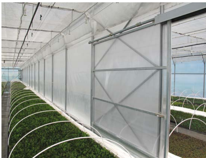
Nowy tunel podzielono na dwie części, w których można utrzymywać odmienne parametry klimatu
