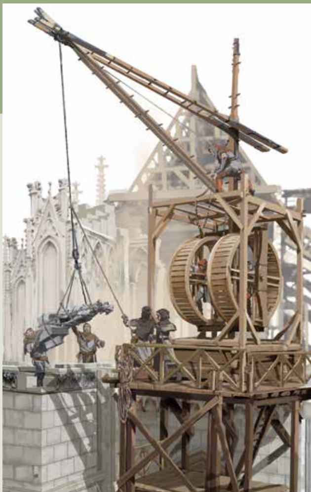
Egy gótikus katedrális építése ■ A kép alapján beszélj arról, hogyan tudták a nehéz köveket a helyükre emelni!
