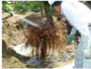
①根を洗い土質を除去する
