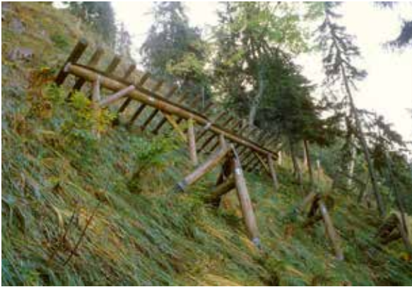
Abbildung 6: Lawinenschutzverbauung aus unbehandelter Kastanie. Foto: Holzforschung München
