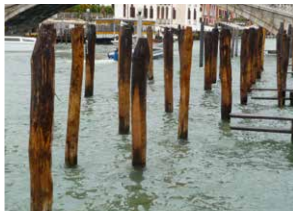
Abbildung 5: Anwendung von Edelkastanie im Spielplatzbau, Garten- und Wasserbau (rechts). Fotos: Holzforschung München
