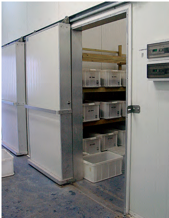
Komory chłodnicze do przechowywania i stratyfikacji nasion w szkółce kontenerowej Nadleśnictwa Rudy Raciborskie – fot. K. A.
