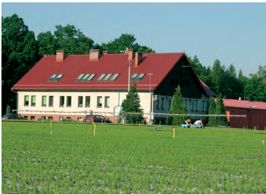
Budynek socjalno-produkcyjny szkółki kontenerowej w Nadleśnictwie Rudy Raciborskie
