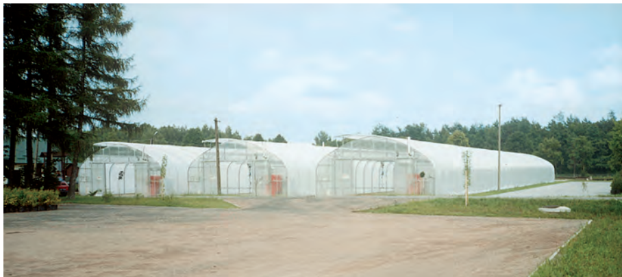
Tunele foliowe w szkółce Nadleśnictwa Oleszyce – system wietrzenia poprzez uchyłne połacie dachowe
