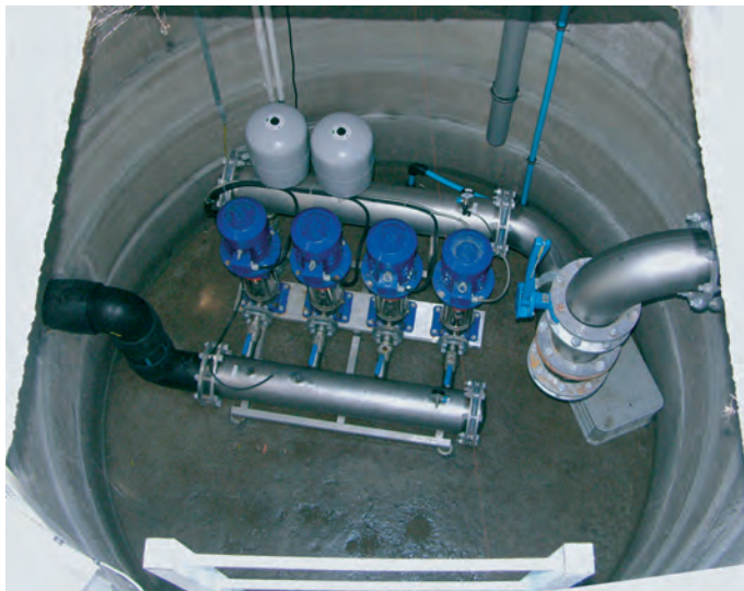
Umieszczenie zestawu pomp w podziemnej studni eliminuje konieczność budowy budynku hydroforni
