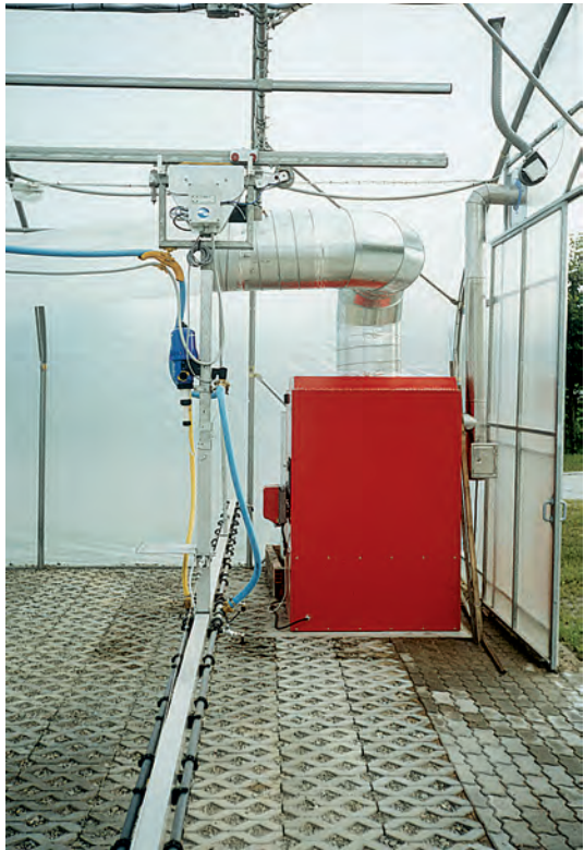
Piec grzewczy w namiocie foliowym – widoczny foliowy rękaw rozprowadzający ciepłe powietrze (Nadleśnictwo Rudy Raciborskie)
