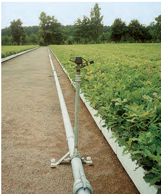
Nawadnianie w szkółce kontenerowej Nadleśnictwa Oleszyce za pomocą klasycznej, stacjonarnej deszczowni
