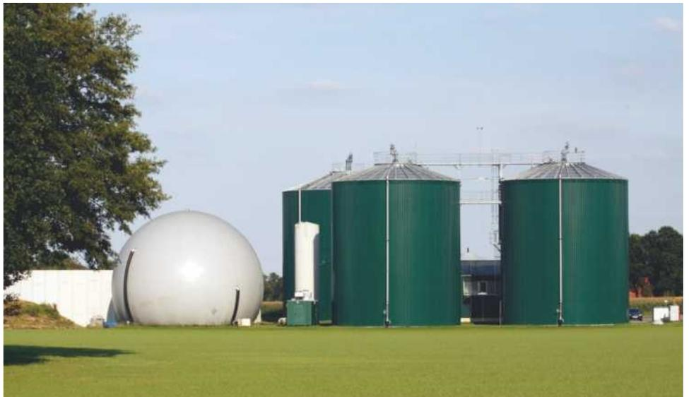
*In der Landwirtschaft wird die meiste Biomasse in Biogasanlagen zu Biogas umgewandelt. Eine weitere Möglichkeit der Biomassenutzung ist die Verbrennung zum Beispiel in Biomasse-Heizkraftwerken.*
