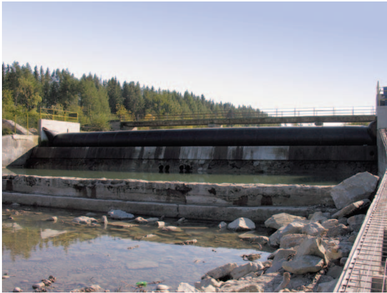
Ryc. 3. Jaz piętrzący z zamknięciami gumowymi na Czarnym Dunajcu w Podczerwonym wykorzystywany do celów energetycznych (fot. B. Wyźga; 2009 r.)
