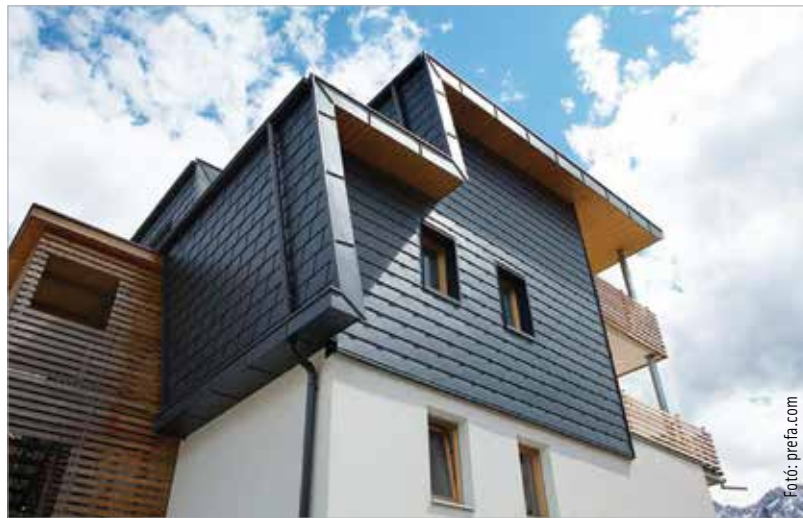
Ugyanaz a burkolóanyag a tetőn és a homlokzat egy részén is
