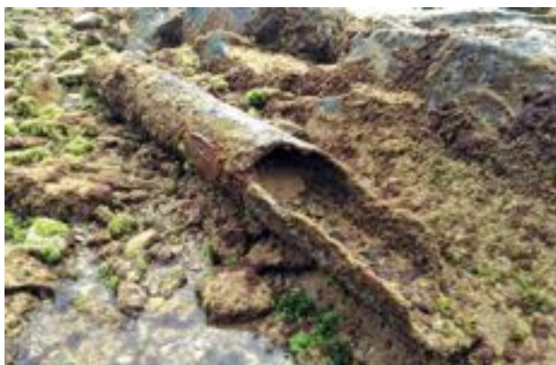
Figura 17. Fragmento del antiguo emisario de la piscina de agua marina (01-09-2019).
