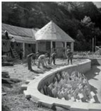
Figura 16. Construcción de la piscina de agua marina del RCTSS (12-07-1954). www.mcu.es
