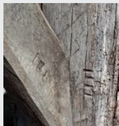
Vista de uno de los postes enterizos conservados del caserío Bizkar (Aia). En el recuadro una las diversas muescas de carpintería de ensamblaje. 📷 A. MORAZA
