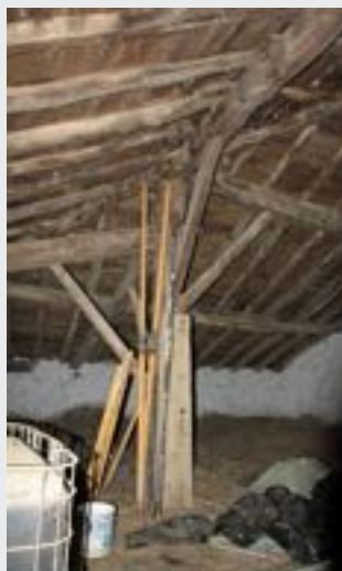
Poste central único relacionado con la construcción original del caserío Pikoaga (Azkoitia) -¿siglo XVI?. Dcha., perspectiva de la compleja estructura portante de la cubierta.
