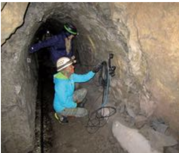
Jaizkibel. Túnel de Pasaia. Teléfono en la parte central, caudales de infiltración y tubería colectora.
