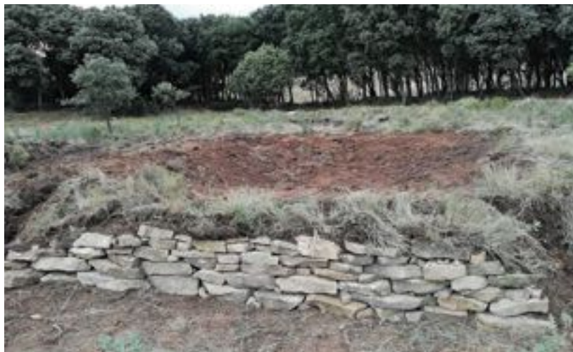
Encharcamiento con murete de piedra seca creado en el municipio de Laguardia.
