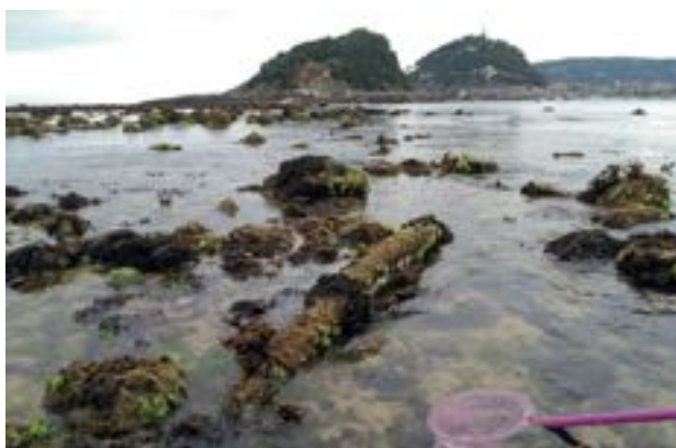
Figura 18. Tubo de PVC recubierto que se retuerce y eleva del fondo.
