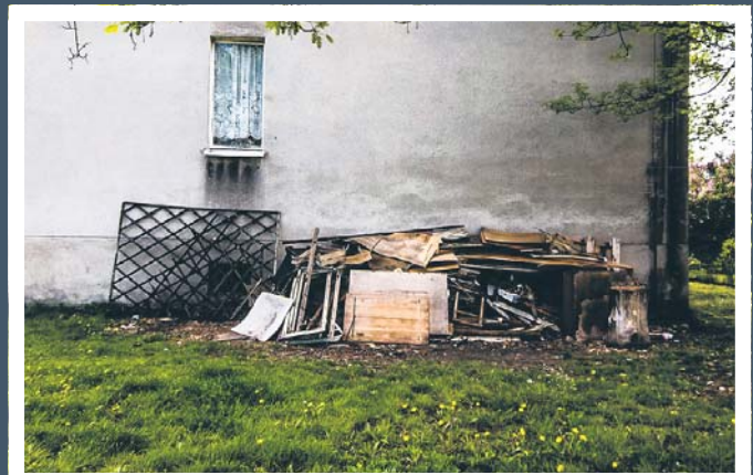
UL. ŚWIERKOWA 4. Pożywka dla kolejnego pożaru?
