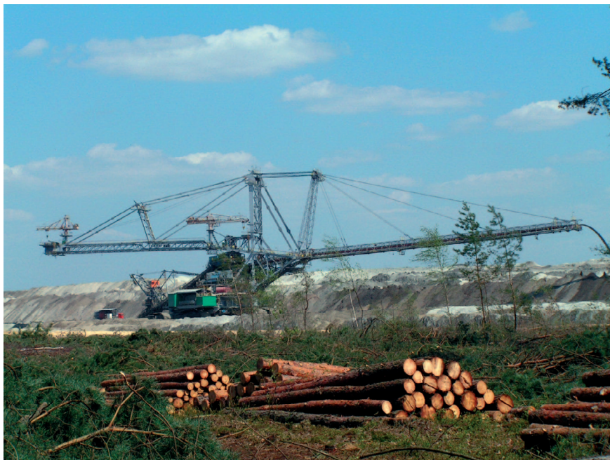
Fot. 5.1. Usuwanie drzewostanów przed frontem eksploatacyjnym – Archiwum LP (fot. R. Nowak)
