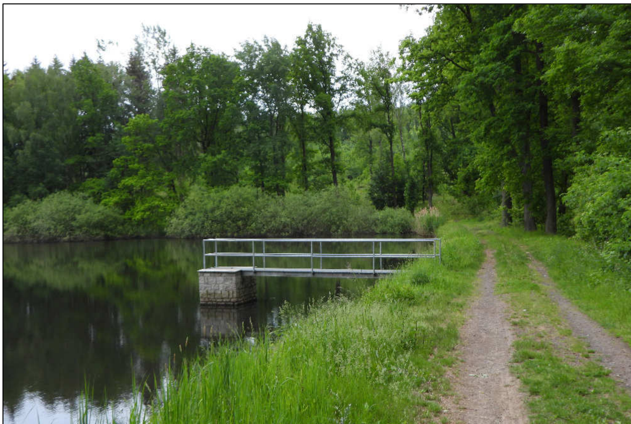
Pohled na hráz Černého rybníka (RK)
