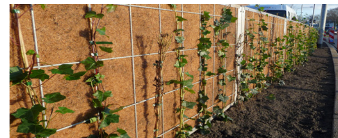
net aangeplante klimop op geluidswerende voorziening met kokosvezel
