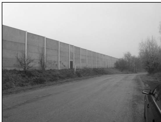
Obr. 2: Protihluková stěna u Rudné u Prahy.
