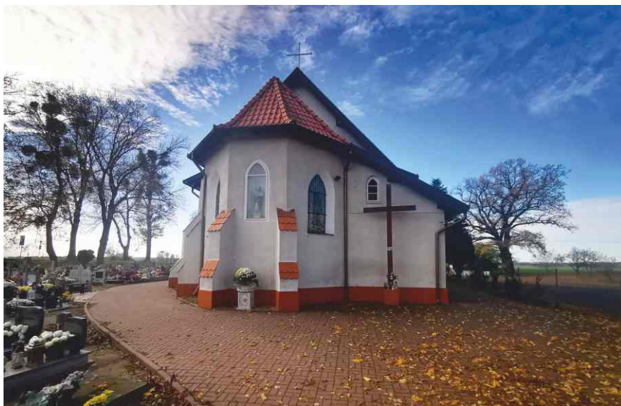
Kościół w Wielkim Lubieniu z zaznaczonym poziomem wielkiej powodzi (fot. Piotr Szumigaj)
