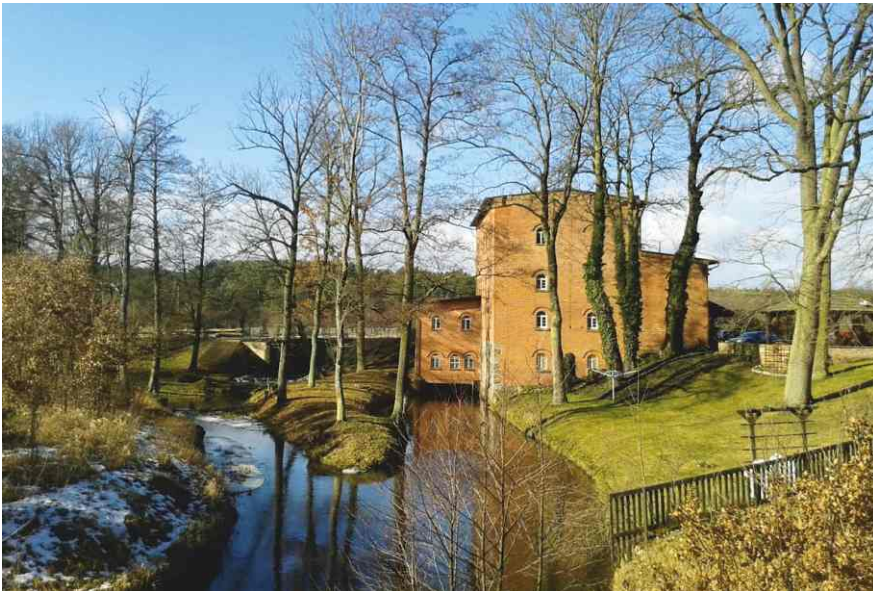
Piła-Młyn. Budynek dawnego młyna, dziś mała elektrownia wodna i mieszkanie (fot. Internet) http://pilamlyn.pl/portfolio-project/mala-elektrownia-wodna-pila-mlyn/ (dostęp 5.11.2020)
