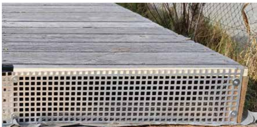
Versuchsterrasse mit 15 Zentimeter Aufbauhöhe und stirnseitigem Verschluss mit einem Lochblech mit 50 Prozent Lochanteil.
