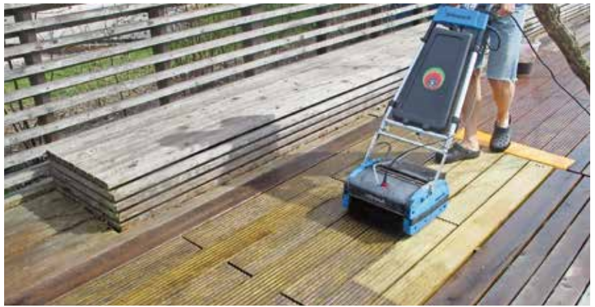
Reinigung einer stark verschmutzten Holzterrasse mit einer Bürstmaschine.
