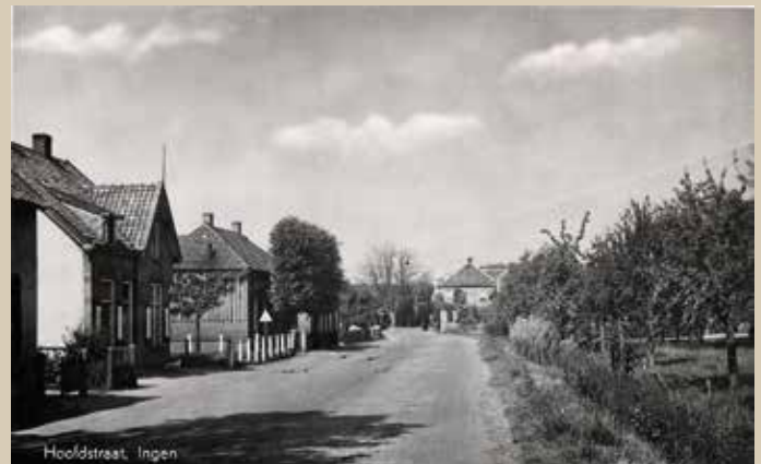
Ingen , een mooie ansichtkaart van de huidige Dorpsstraat. In vroeger jaren droeg deze straat ook nog de namen Hoofdstraat en Ambachtstraat. De boomgaard rechts moest plaatsmaken voor de bouw van huizen. Aan de linkerkant was de drogisterij van Pieterneel gevestigd, zo kende iedereen haar. Ze runde haar zaak tot op zeer hoge leeftijd.
