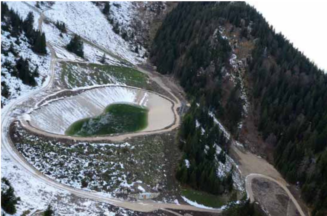
Abb. 18: Mangelnde Wasserqualität im halbvollem neuen Speicherbecken am Brauneck / Lenggries / Obb. (Foto: F. Speer, 5.11.2012).
