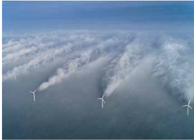
Abb. 11: Wirbelschleppen, die zur Nebelbildung neigen – so kann man den Windparkeffekt sichtbar machen. Das Bild zeigt den Windpark "Horns Rev 1" vor der dänischen Nordseeküste südwestlich von Blåvandshuk, 14 bis 20 Kilometer vor der Küste.
