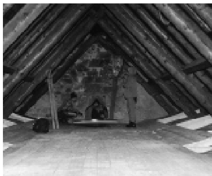
Fot. 4. Platforma zabezpieczająca strop kościoła (fot. S. Telatyński).
