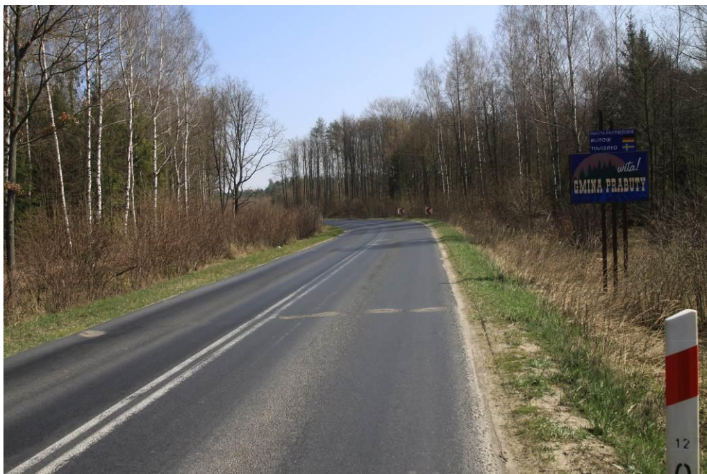
Fot. 14. Widok w kierunku wschodnim- km ok. 12+000
