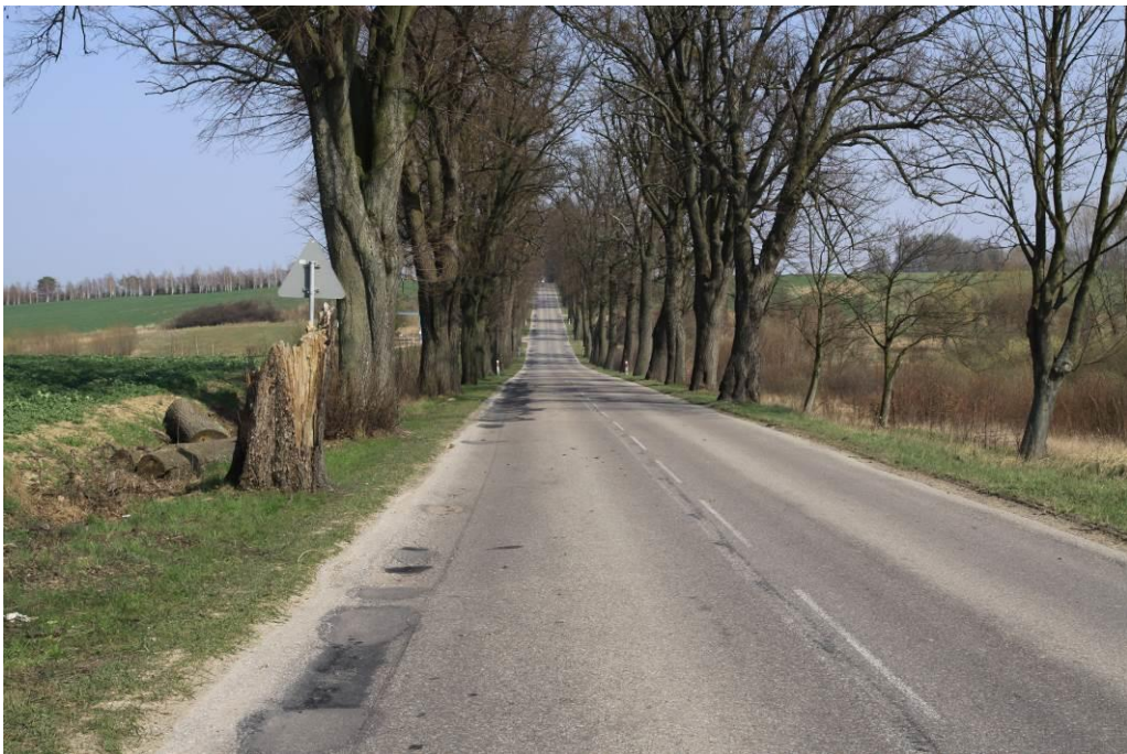
Fot. 10. Widok w kierunku wschodnim- km ok. 7+600
