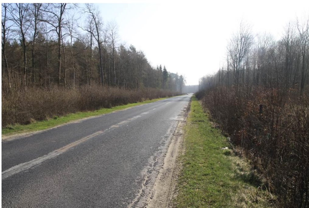
Fot. 16. Widok w kierunku zachodnim- km ok. 15+000
