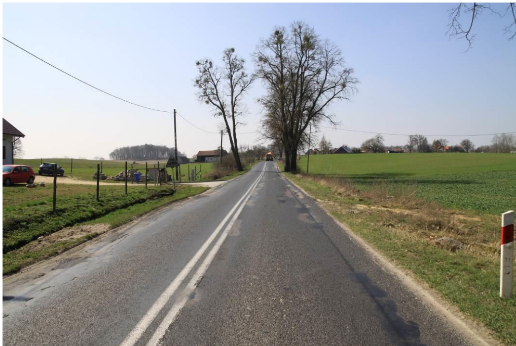
Fot. 13. Widok w kierunku zachodnim- km ok. 10+500
