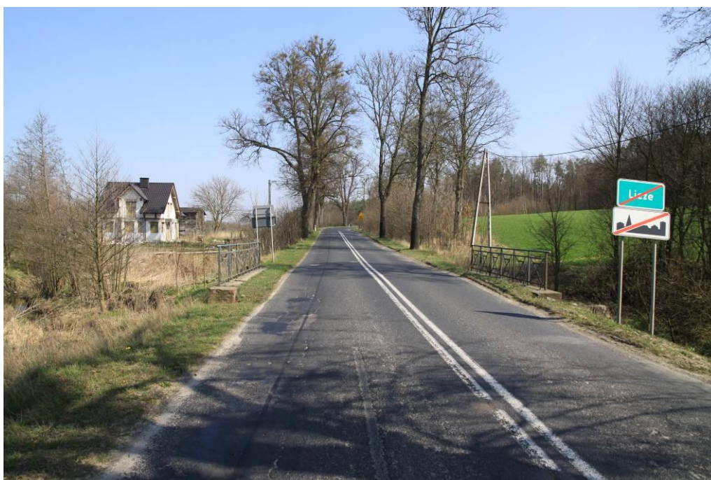
Fot. 12. Widok w kierunku wschodnim- km ok. 10+500
