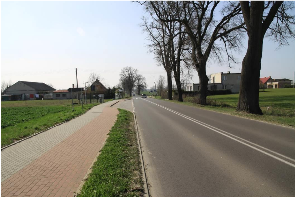
Fot. 9. Widok w kierunku zachodnim- km ok. 4+900
