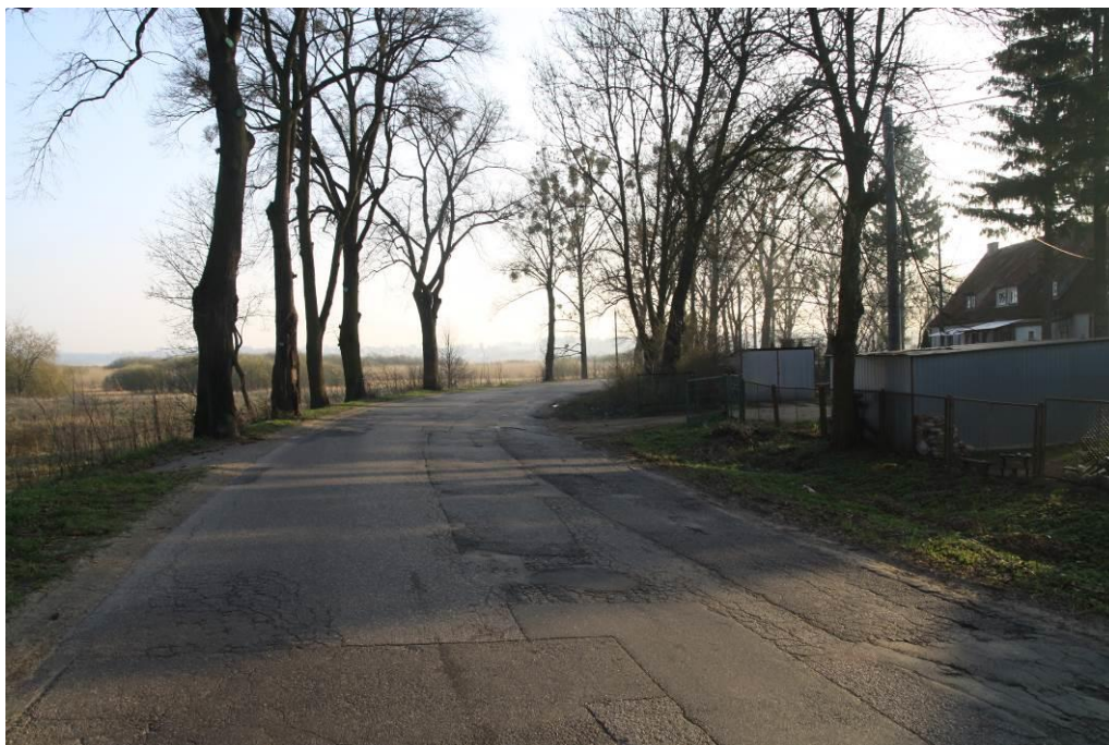
Fot. 19. Widok w kierunku wschodnim- km ok. 17+500
