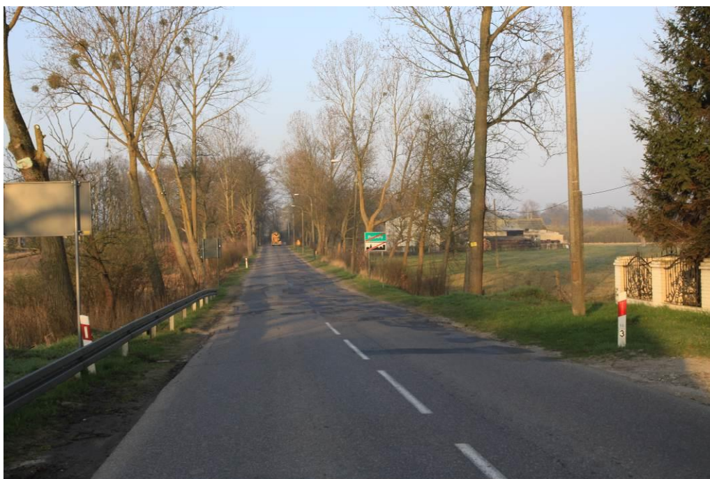
Fot. 22. Końcowy odcinek planowanego przedsięwzięcia - widok w kierunku zachodnim- km ok. 18+300
