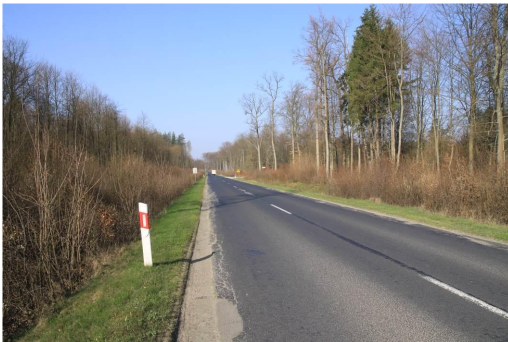
Fot. 17. Widok w kierunku wschodnim- km ok. 15+000
