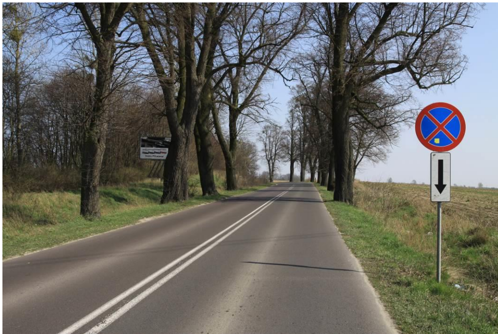
Fot. 7. Widok w kierunku zachodnim - km ok. 2+900
