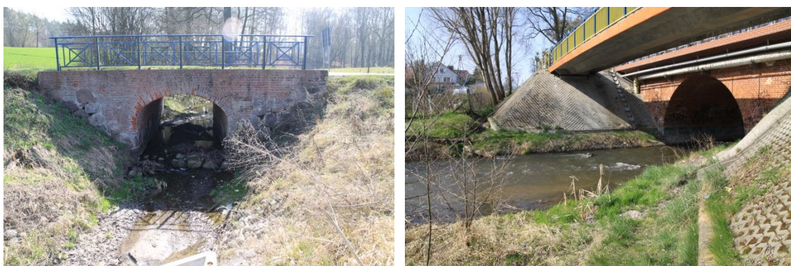
Rys.22. Obiekty pełniące funkcję przejść dla zwierząt małych – w m. Licze oraz na rzece Linawa w Kwidzynie.
