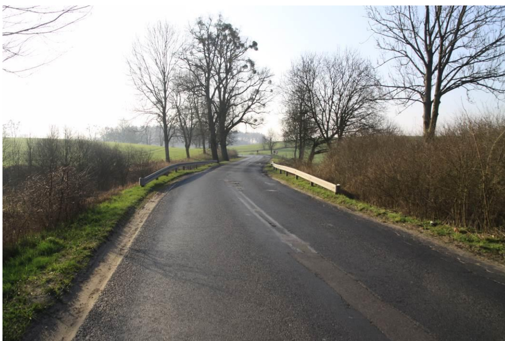
Fot. 18. Widok w kierunku wschodnim- km ok. 16+000
