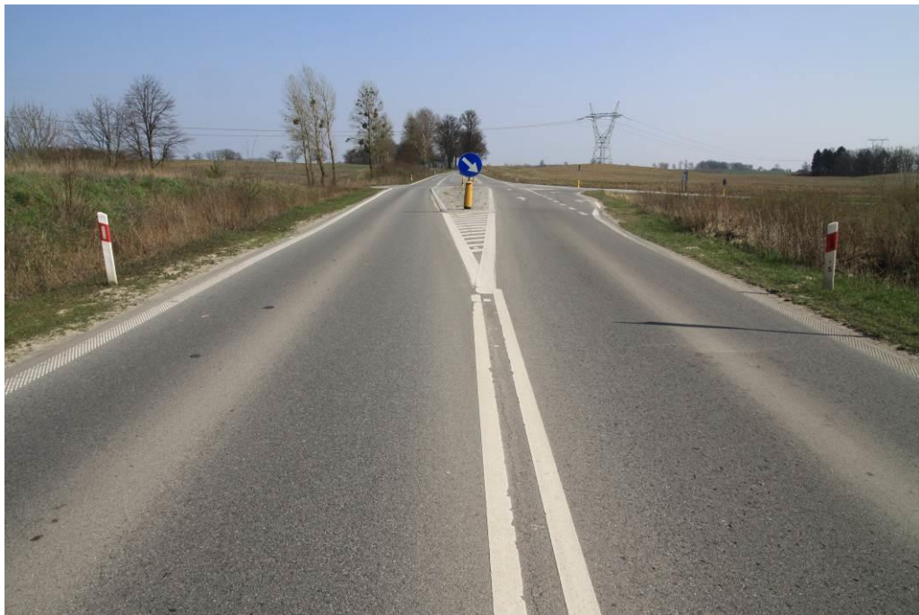
Fot. 4. Widok w kierunku wschodnim- km ok. 2+500
