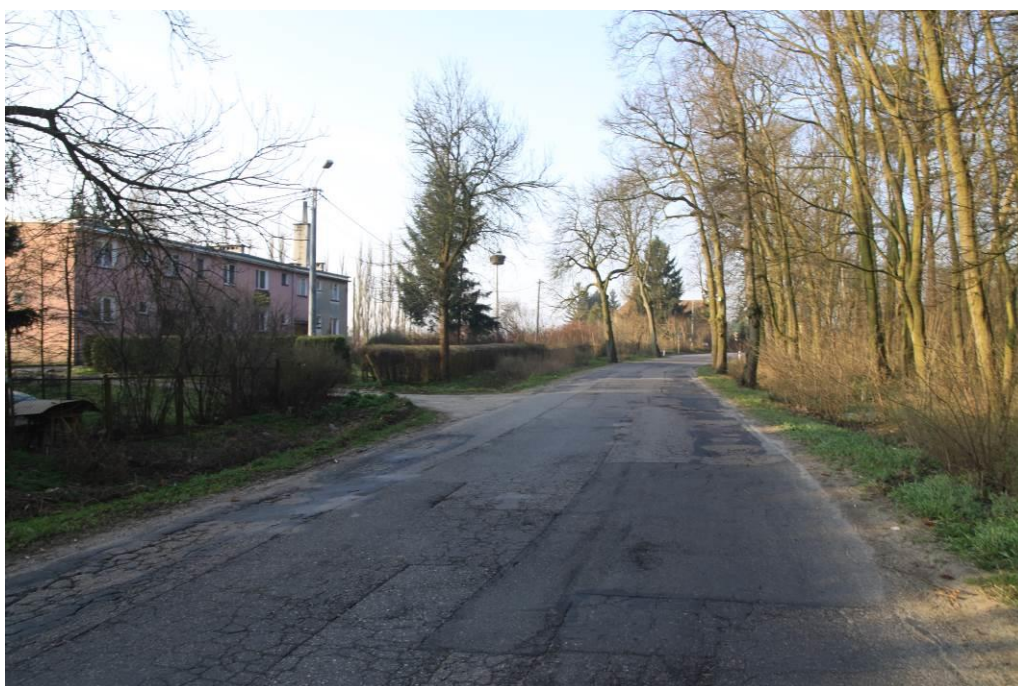
Fot. 20. Widok w kierunku zachodnim- km ok. 17+500
