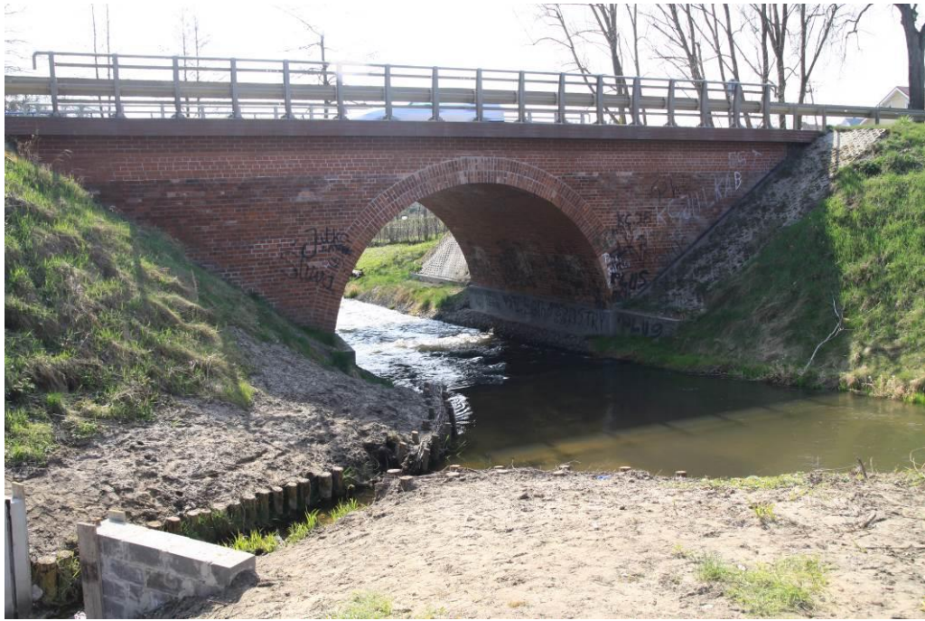
Fot. 3. Obiekt mostowy na rzece Liwa w Kwidzynie
