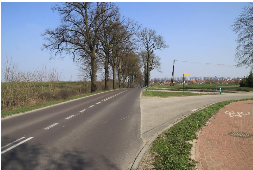
Fot. 8. Widok w kierunku wschodnim- km ok. 4+900
