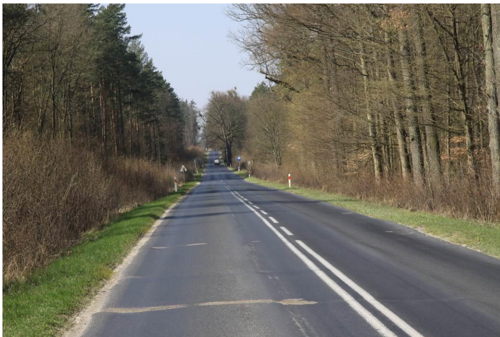
Fot. 15. Widok w kierunku zachodnim- km ok. 12+000
