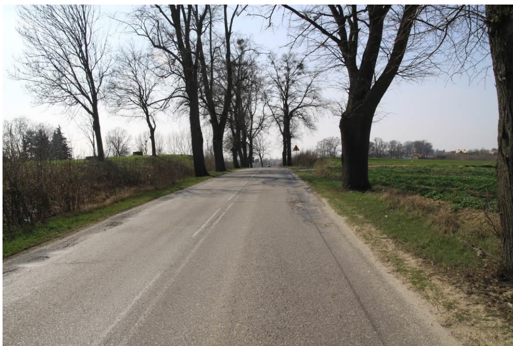
Fot. 11. Widok w kierunku zachodnim- km ok. 7+600
