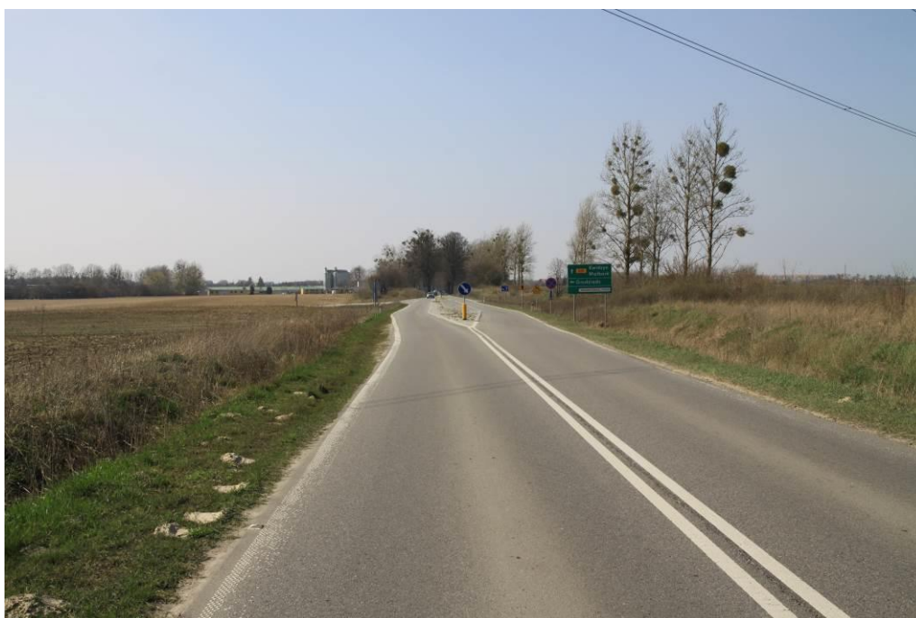
Fot. 6. Widok w kierunku wschodnim- km ok. 2+900
