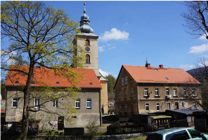
Fot. 36. Budynki dawnej szkoły ewangelickiej i dawnej plebanii oraz wieża kościoła św. Jadwigi – widok od zachodu
