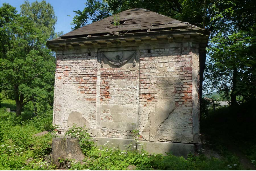
Fot. 40. Kaplica grobowa Christiana Friedricha Klingberga – elewacja południowa
