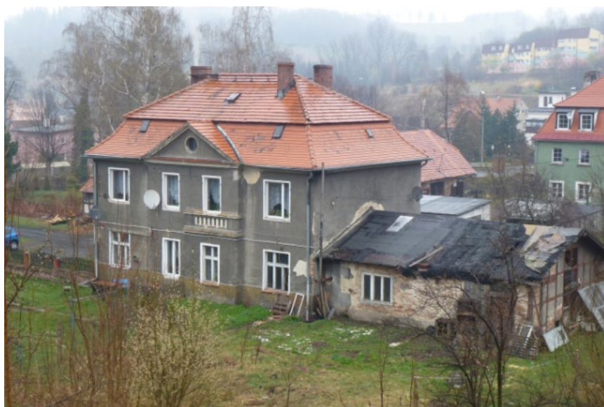
Fot. 84. Budynek dawnego dworca. Elewacja zachodnia, od strony peronu
