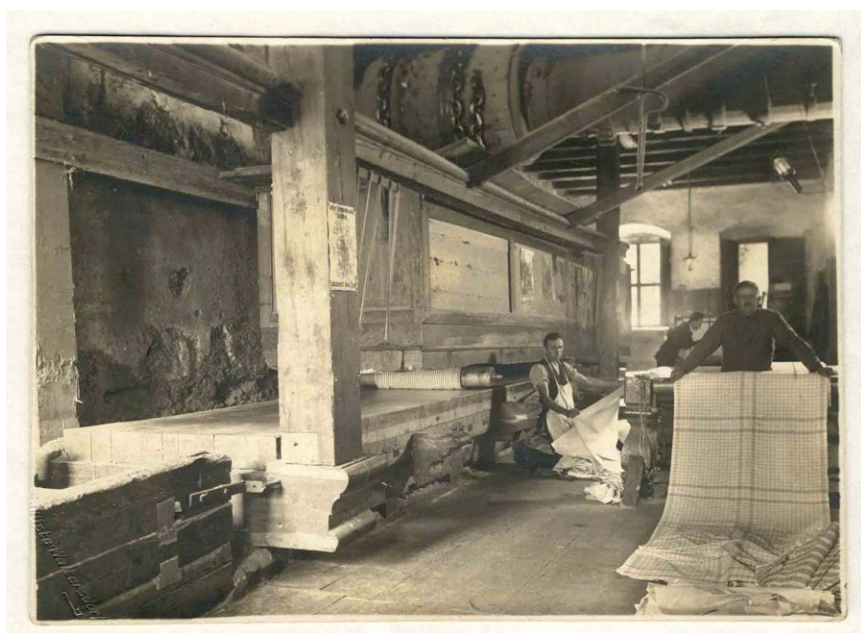
Fot. 9. Wnętrze magła wodnego
