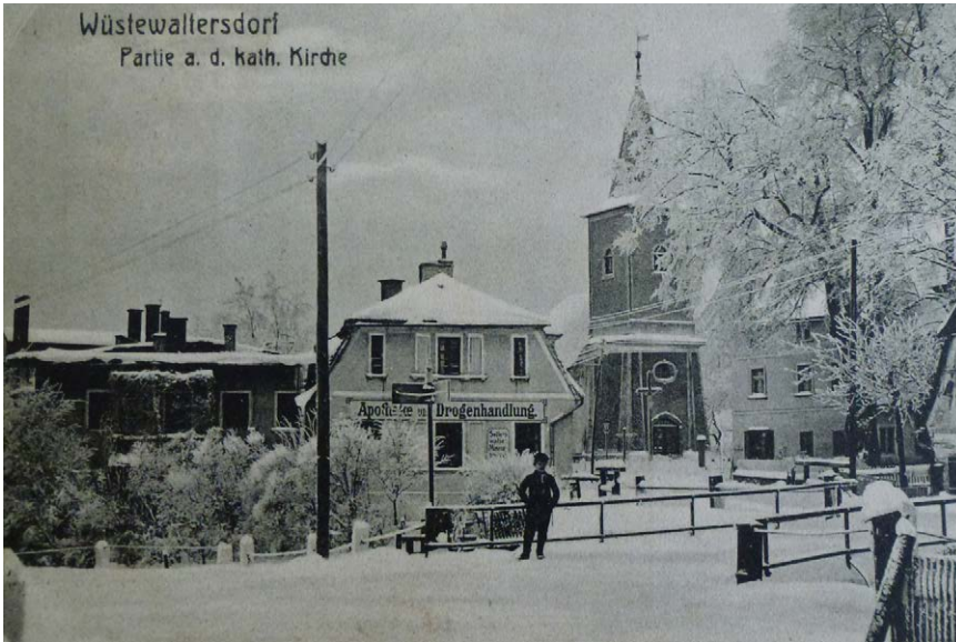
Fot. 51. Dom przy obecnej ulicy Wyszyńskiego 3 – od 1807 r. w budynku mieściła się re-sursa kupiecka, a od 1848 r. przez wiele lat funkcjonowała apteka
