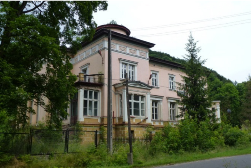
Fot. 72. Willa Heinricha Schneidera, ulica Wyszyńskiego 92, elewacja zachodnia
