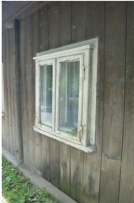
Fot. 4. Wiejski dom drewniany przy ulicy Wyszyńskiego 42, oryginalne drewniane ramy okienne wysunięte poza lico ściany
