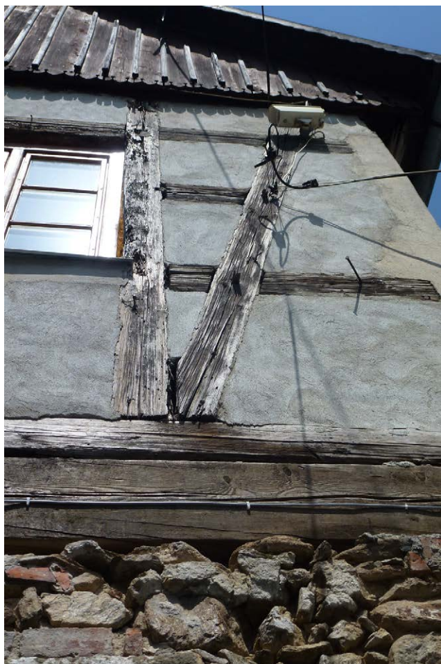
Fot. 11. Fragment elewacji południowej dawnego mąglu wodnego – widoczna konstrukcja z kamienia polnego w parterze budynku i konstrukcja ryglowa na piętrze, czerwiec 2014
