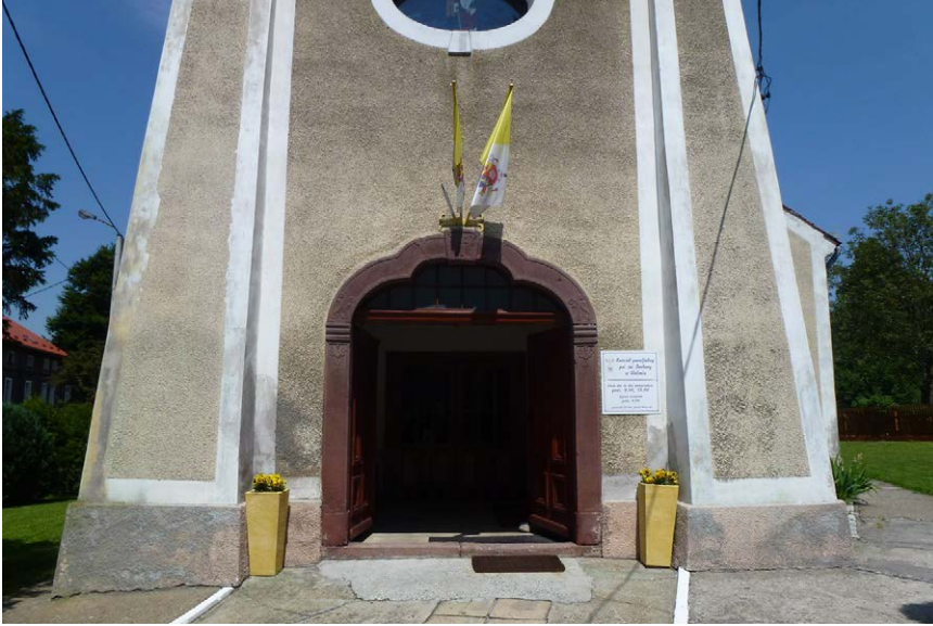
Fot. 29. Portal z roku 1777 w wieży kościoła św. Barbary
