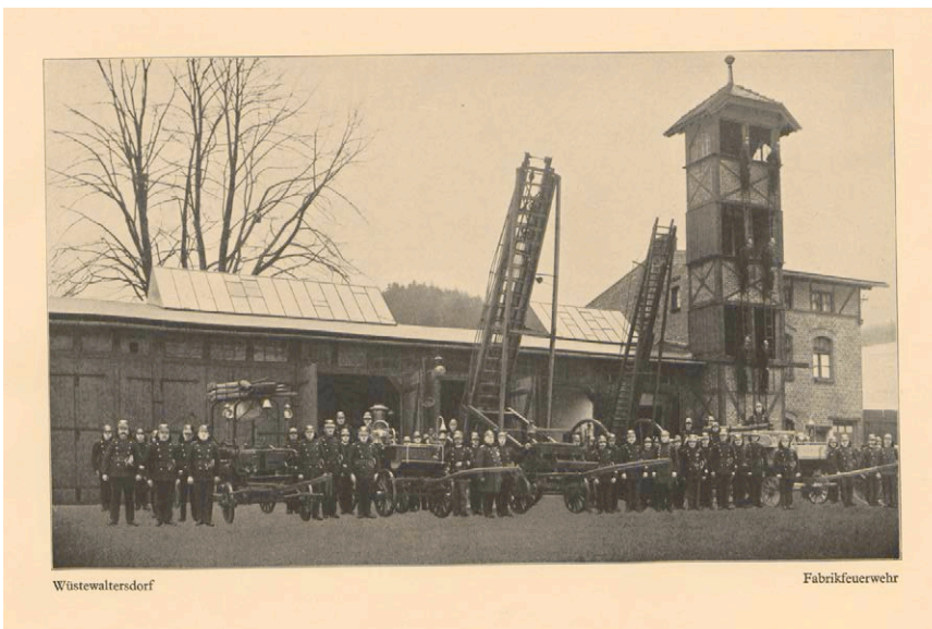
Fot. 82. Remiza: budynek socjalny, wieża ćwiczebna i garaże wozów bojowych. Na pierwszym planie siedem siedmioosobowych drużyn strażackich w galowych mundurach
