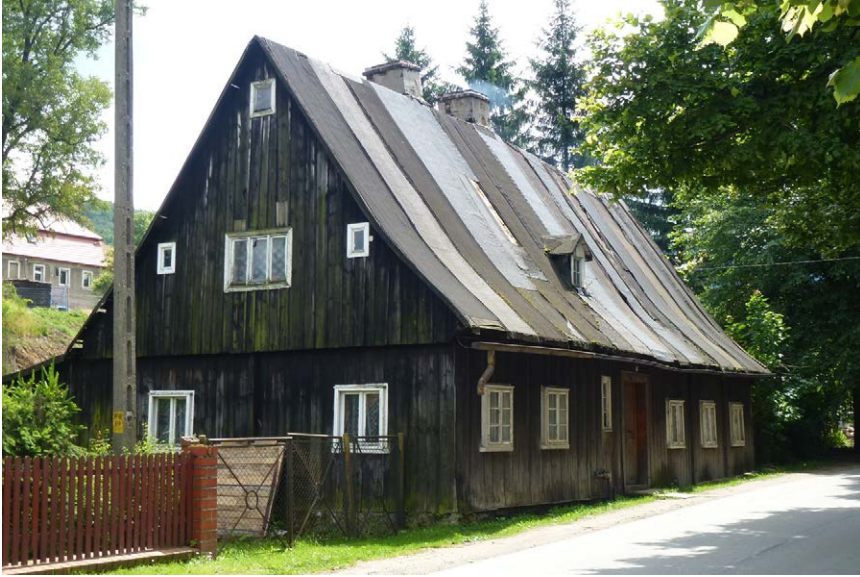
Fot. 3. Wiejski dom drewniany przy ulicy Wyszyńskiego 42, widok ogólny
