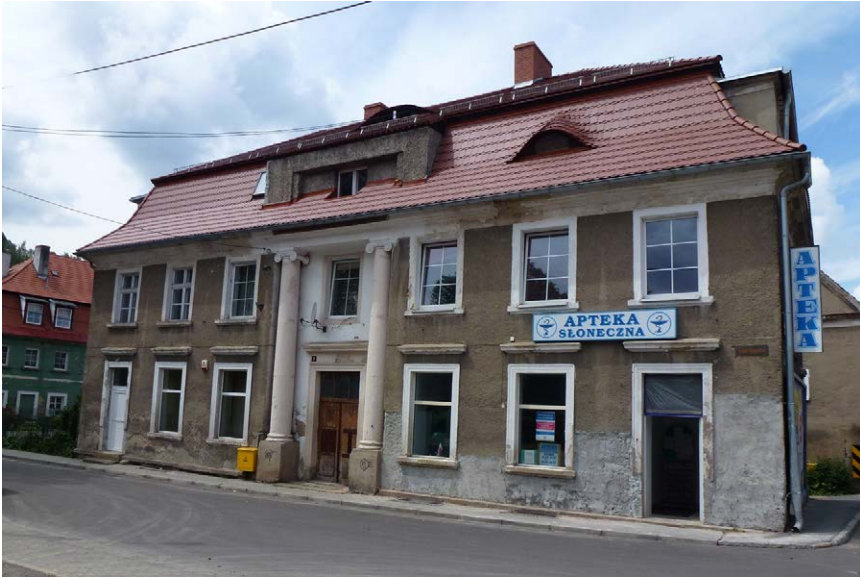
Fot. 15. Posiadłość kupiecka przy ulicy Konopnickiej 2; za główną bryłą domu znajduje się dziedziniec i zabudowania gospodarcze. Od 1793 r. posiadłość znajdowała się w rękach rodziny Hauptów, a jej wcześniejszym właścicielem był dziedzic wsi Carl Abraham von Zedlitz
