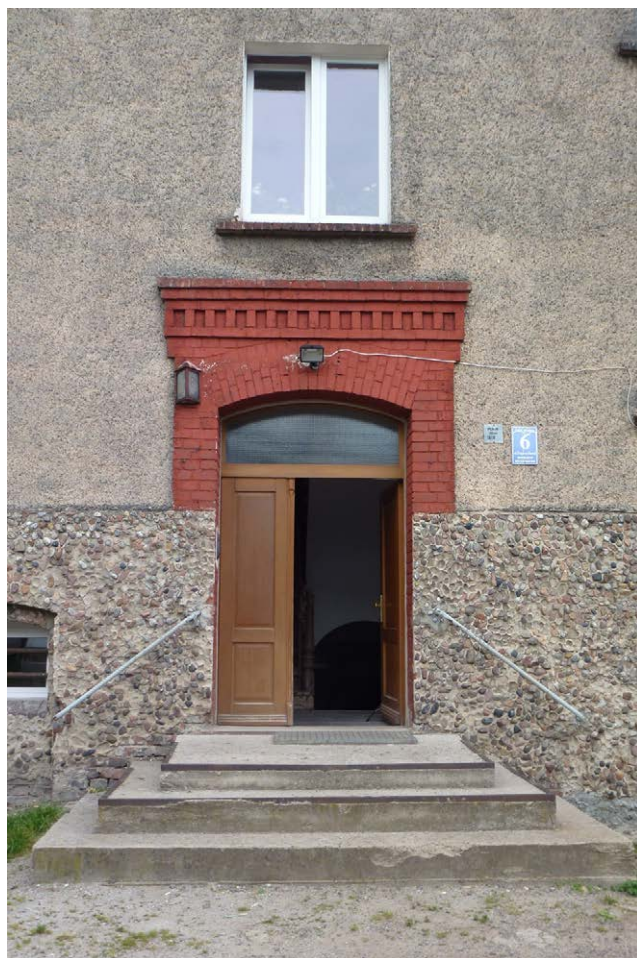
Fot. 75. Wejście do budynku mieszkalnego przy ulicy Wzgórze Wawel 6
