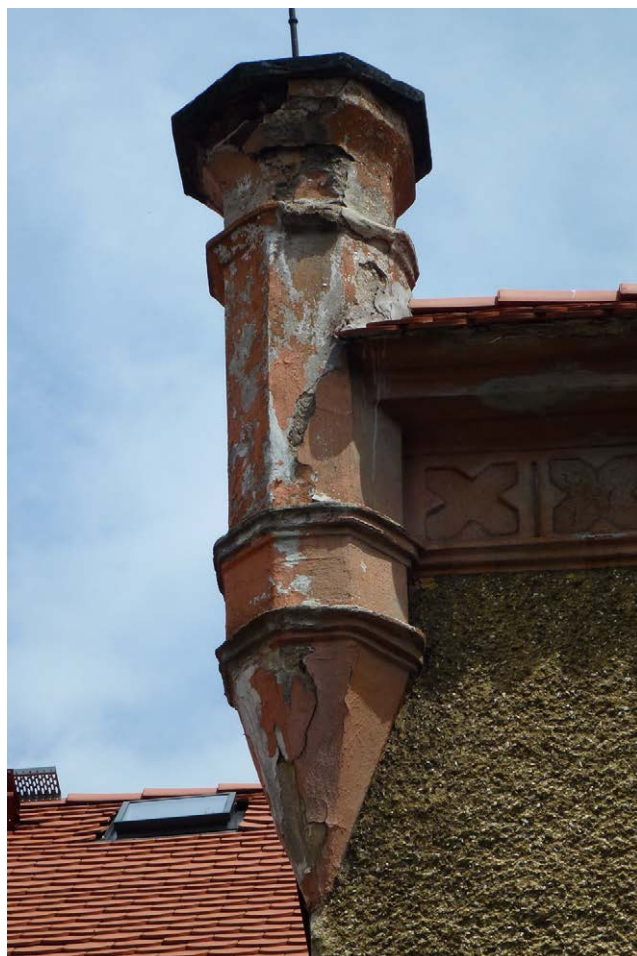
Fot. 44. Sterczyna i fragment gzymsu i fryzu w elewacji dawnego zajazdu „Gasthaus zur Eule”
