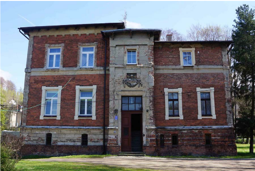
Fot. 64. Willa przy ulicy Kościuszki 11, elewacja zachodnia
