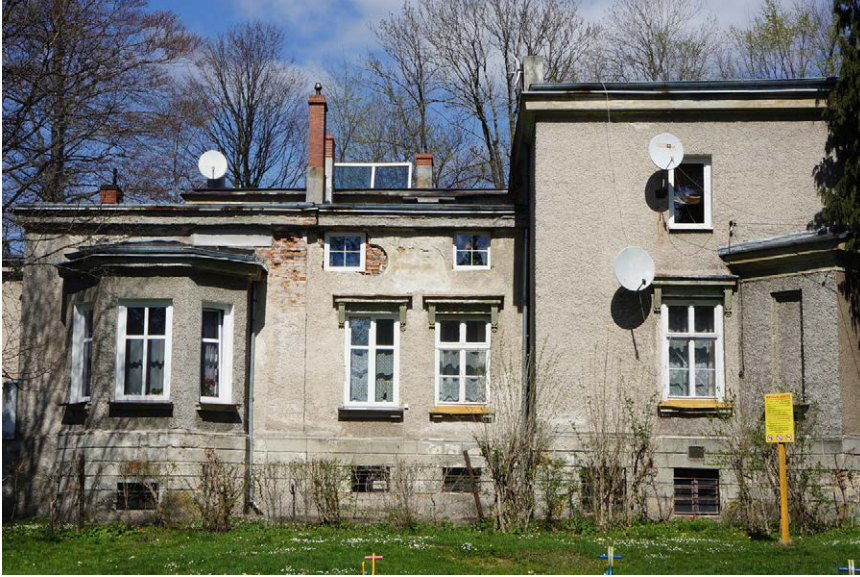
Fot. 68. Willa przy ulicy Kościuszki 13 wybudowana dla Karla Hartmanna, elewacja południowa
