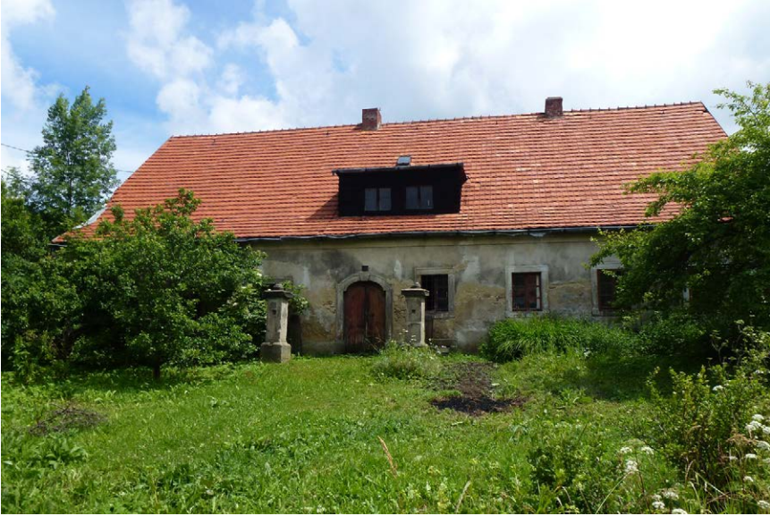
Fot. 19. Dom Friedricha Gottfrieda Seylera z 1782 r.; kamienne filary stojące około 3 m przed budynkiem podkreślają wejście główne od strony ulicy Wyszyńskiego
