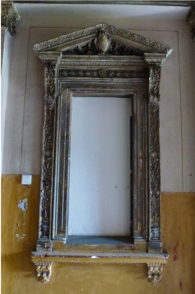
Fot. 67. Edykułowe obramienie dawnego wewnętrznego okna na ścianie korytarza willi przy ulicy Kościuszki 11
