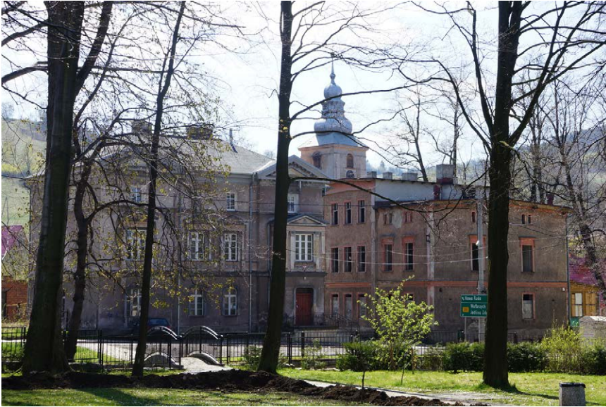
Fot. 81. Budynki dawnej poczty i dawnego kasyna położone przy ulicy Kościuszki, widziane z Parku Jordanowskiego
