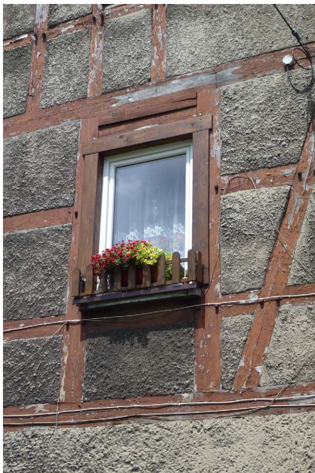
Fot. 21. Konstrukcja ryglowa piętra z autentycznymi drewnianymi kołkami w domu przy ul. Wyszyńskiego 65
