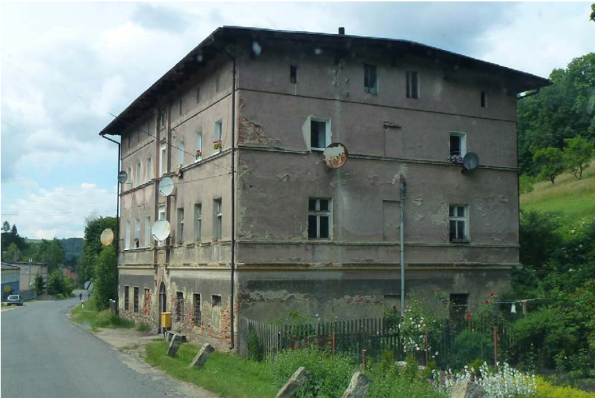
Fot. 14. Budynek dawnej bielarni i farbiarni przebudowany w XIX w. na dom mieszkalny, ulica Wyszyńskiego 86
