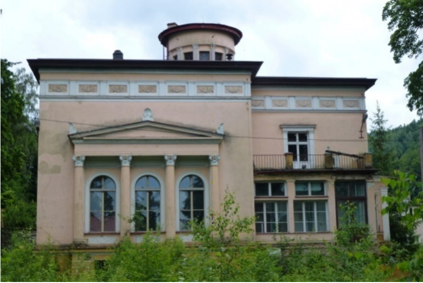
Fot. 71. Willa Heinricha Schneidera, ulica Wyszyńskiego 92: pseudoportyk, wieżyczka w formie gloriety i weranda w elewacji północnej
