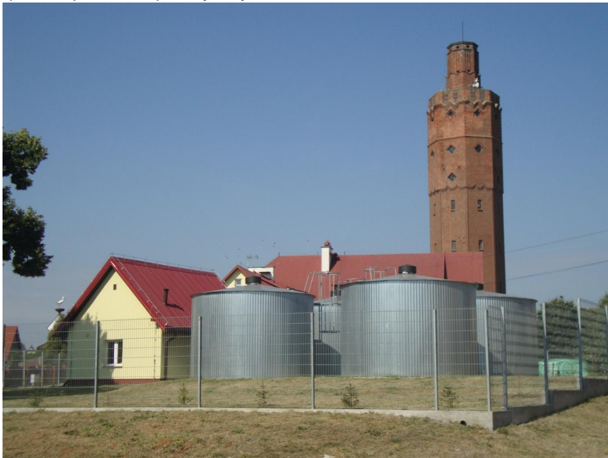
Ryc. 13.2 Stacja uzdatnia wody w Białej Piskiej
