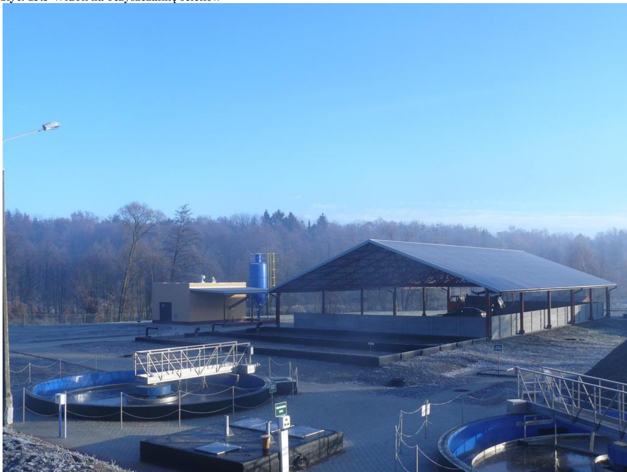
Ryc. 13.3 Widok na oczyszczalnię ścieków
