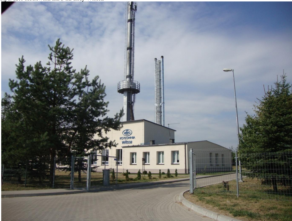
Ryc. 13.6 Kotłownia ZEC na ulicy Witosa
