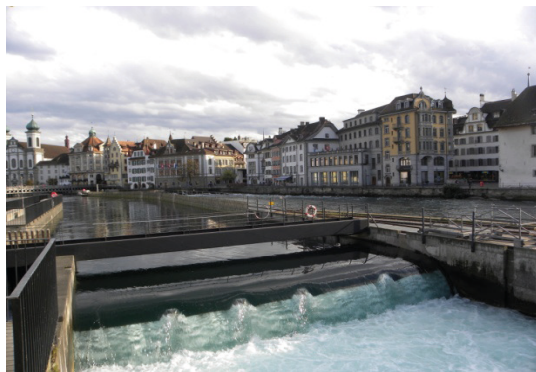
Rysunek 10. Lucerna – Elektrownia wodna na rzece Reuss [fot. E. Latusek]
